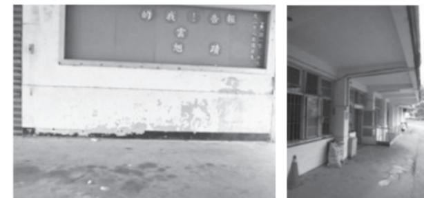
磨石子地坪多處油漬污染 走廊空間地坪多處坑洞
