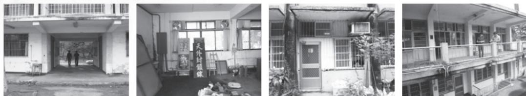
空間A101增設設施現況 (於走廊上增設不銹鋼洗手台) 空間A104增設設施現況 (後期增設的抽風機及設備管線) 空間C102增設設施現況 (後期增設的窗型冷氣及鋁門夾板) 空間C103增設設施現況 (後期增設的設備管線攀附建物)
