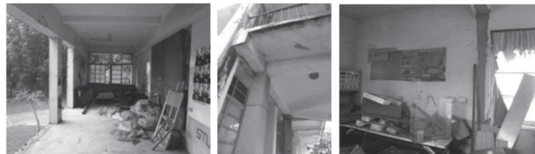
空間C202拆除缺損 空間B206拆除痕跡 空間D101室內隔間牆拆除痕跡
