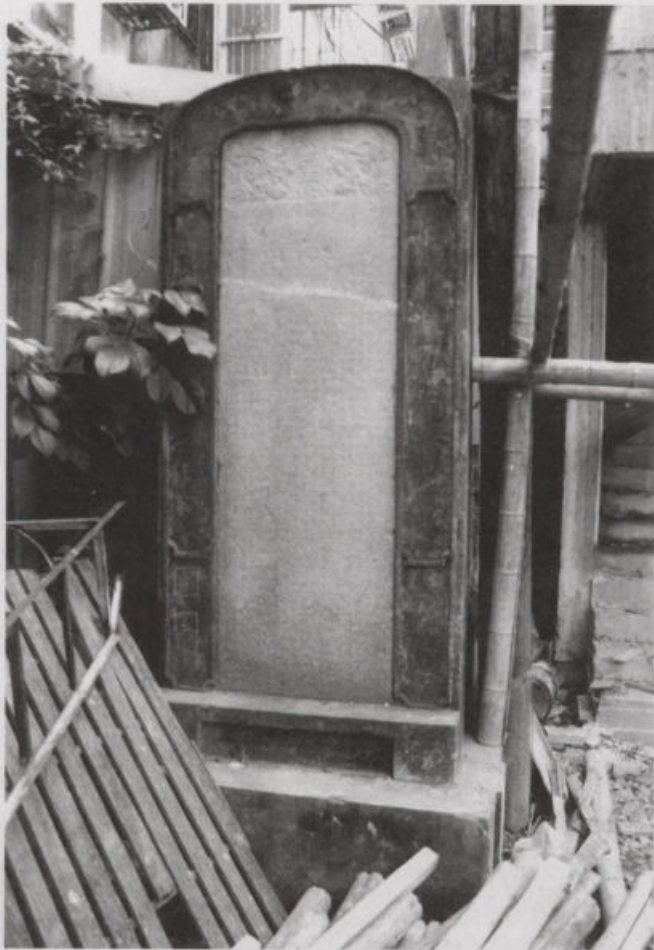
虎尾德興宮【嚴禁奸保蠹差藉屍圖詐碑記】以水泥托背方式置於室外保存，石碑表面有一道修補的斷痕
