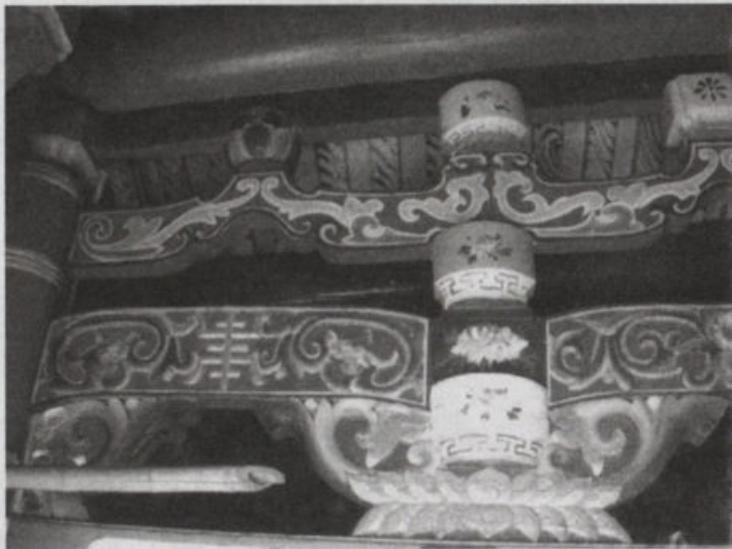
圖4-2 桃彎拱承接雞舌再接桁木
