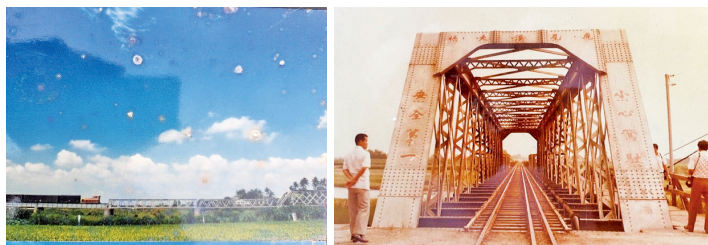
圖 29：左圖為「虎尾溪大橋」三段不同構造全貌；右圖為「虎尾溪大橋」早期風貌，鐵橋右側附建有板仔橋，供民衆往來通行。
