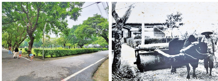
圖 10：左圖為虎尾糖廠宿舍現況；右圖為早期糖廠社區路面滾壓整平施工實況。
